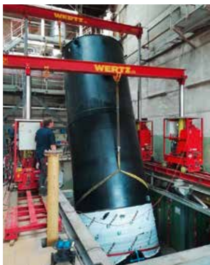
Installation du réservoir
