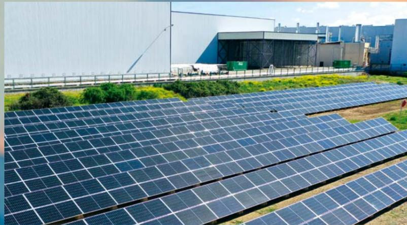
L'énergie produite par l'installation solaire sera > 500.000 kWh/an
