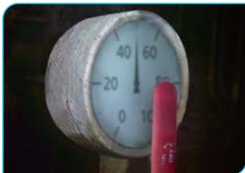
Abb.10 Überhöhter Spritzwasser-Druck
